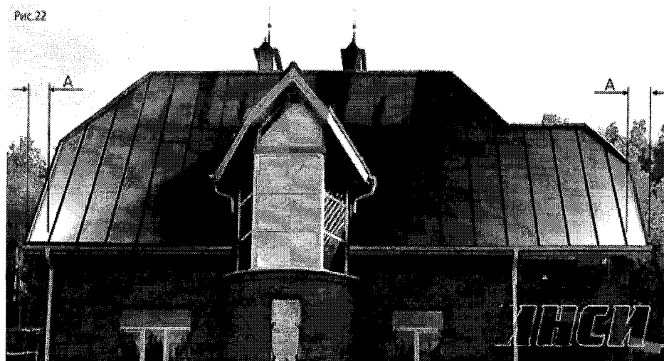
Рис 6. Подрезка крайних листов
